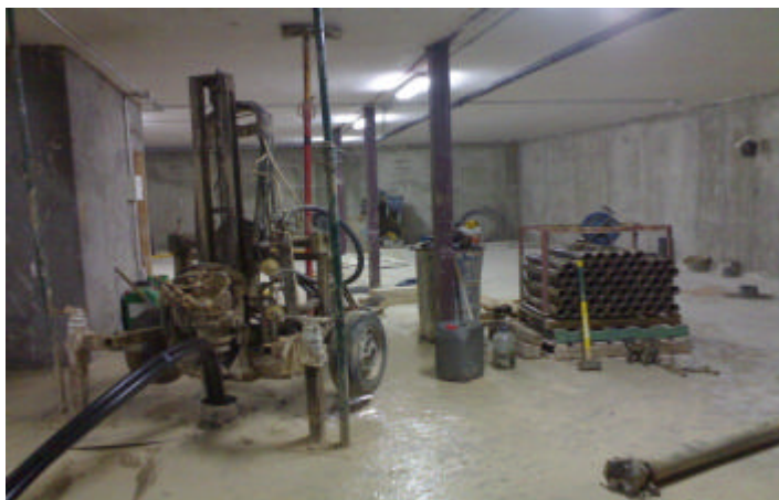
Figura 4. Imagen de la perforación en el interior del sótano del edificio.
